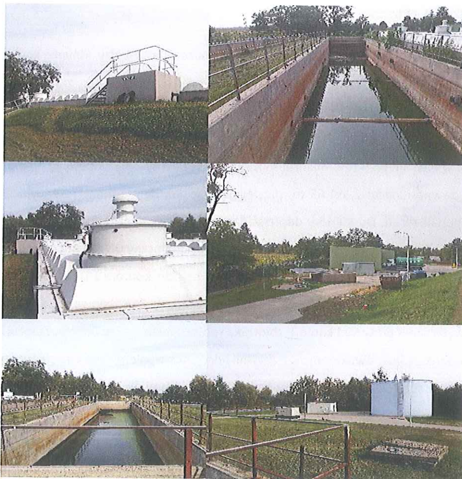
Rysunek 5. Komora ścieków dopływających do zbiornika retencyjnego, przykryte zbiorniki retencyjne, rezerwowe zbiorniki retencyjne, zbiornik wody, budynki garażowo-magazynowe
