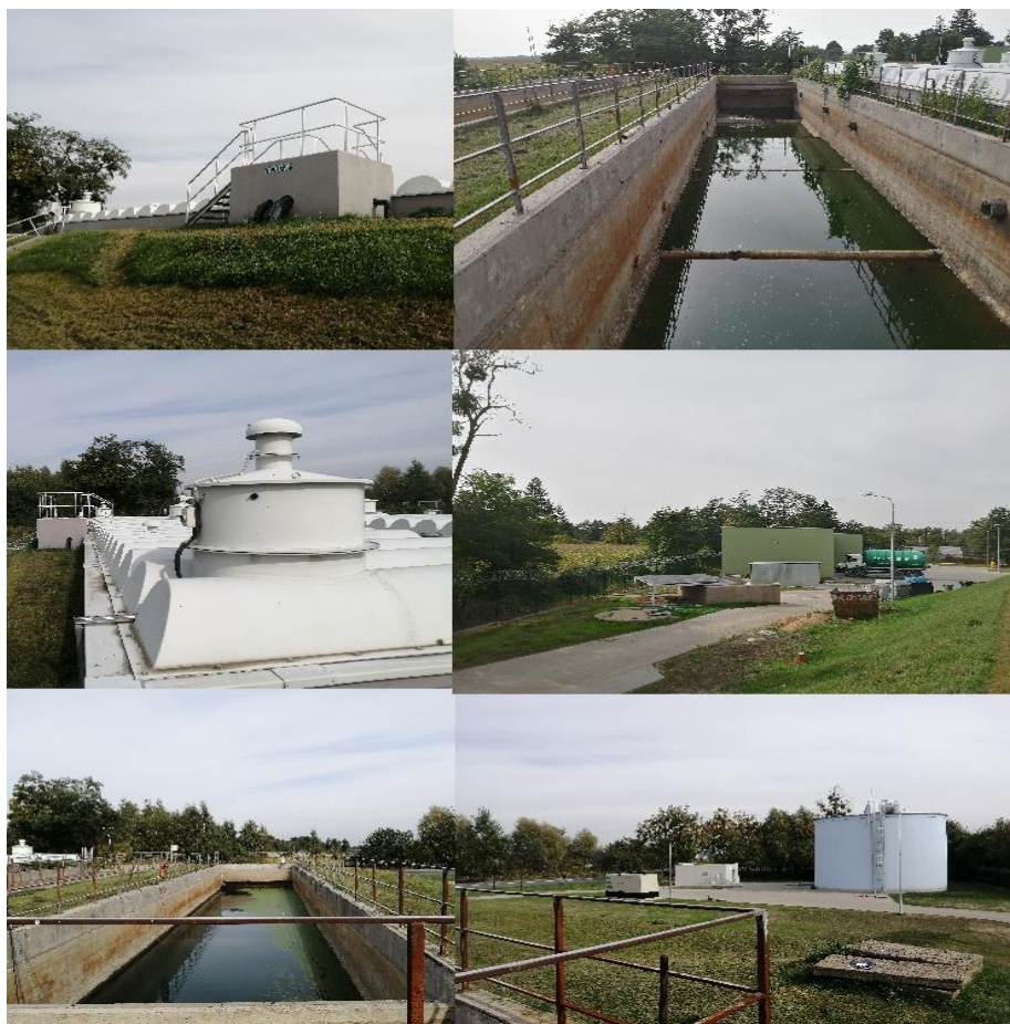
Rysunek 5. Komora ścieków dopływających do zbiornika retencyjnego, przykryte zbiorniki retencyjne, rezerwowe zbiorniki retencyjne, zbiornik wody, budynki garażowo-magazynowe
