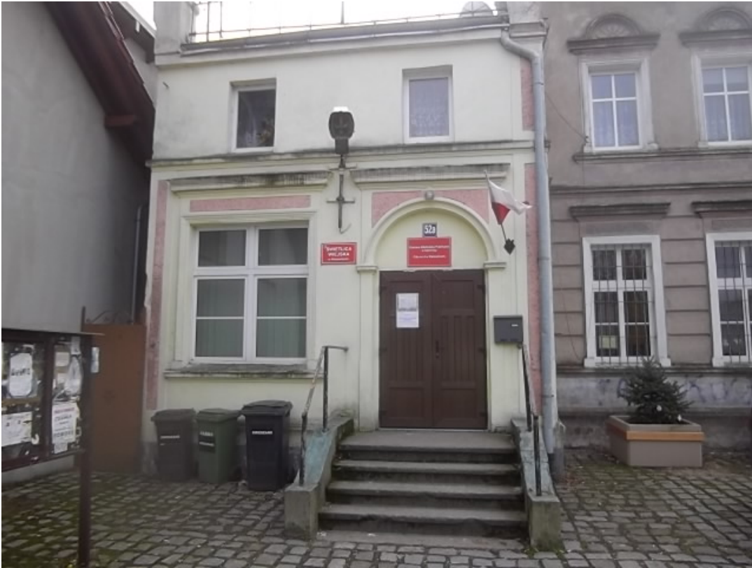
fot. nr 1. Widok frontowy budynku świetlicy wiejskiej w Ratowicach
