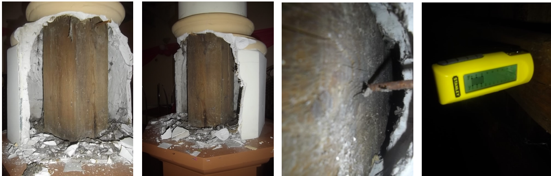
fot. nr 18, 19, 20 i 21 Obraz odkrywek i badania makroskopowego i pomiaru wilgotności słupów
