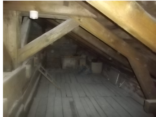
fot. nr 12 i 13 Więźba dachowa nad świetlicą
