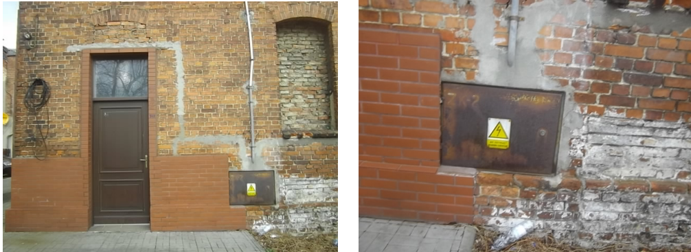
fol. nr 8 i 9. Naruszone sklepienie w części podziemnej
