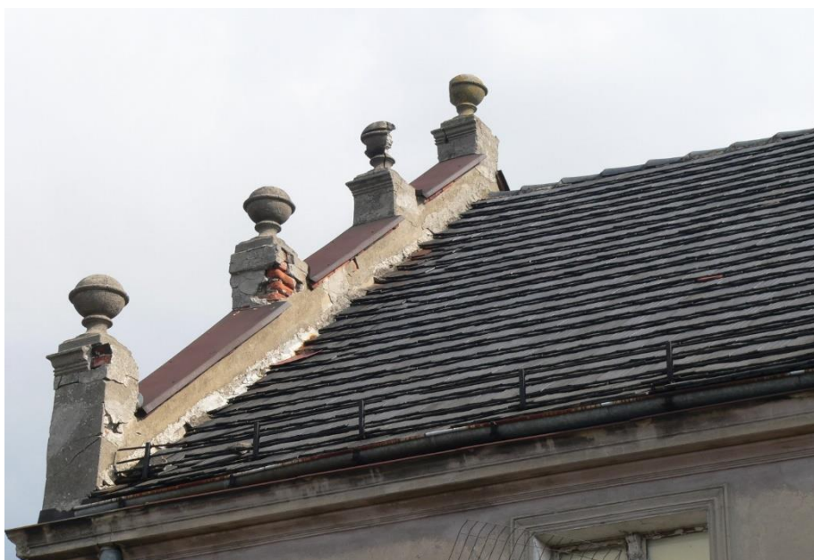
fot. 24 Attyka – zdobienia ,skorodowane obróbki
