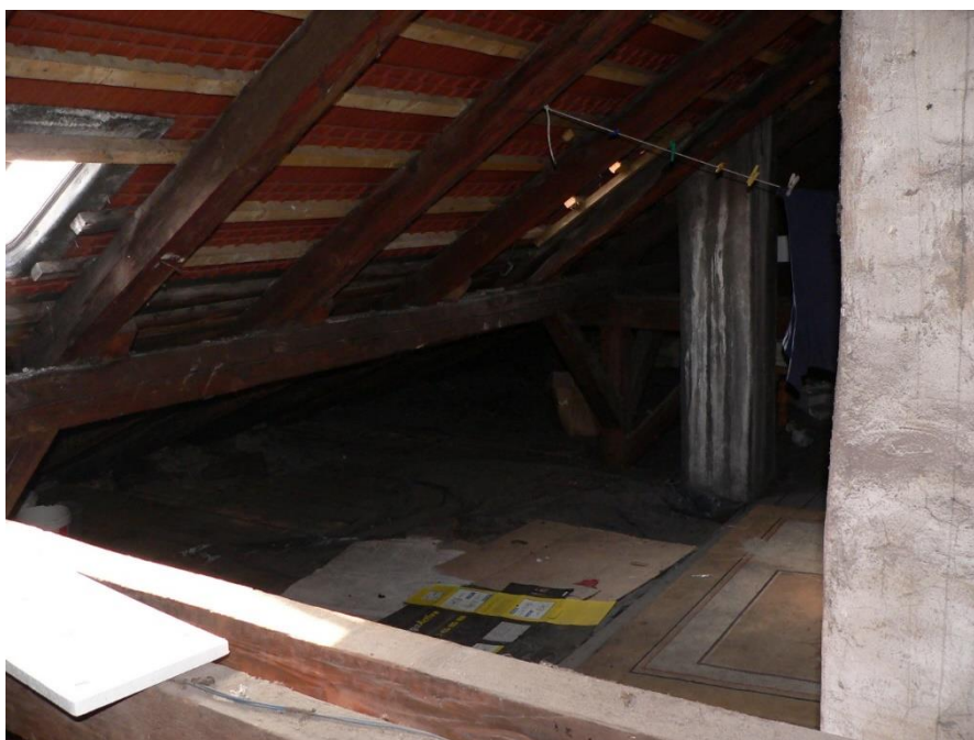
Fot. 49 Strych -fragment połaci z nową dachówką od strony podwórka
