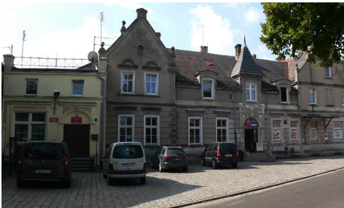
Fot. 17 Elewacja frontowa
