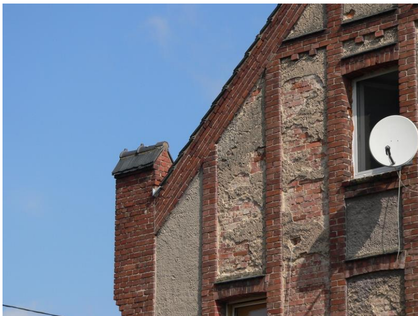
Fot. 10 Uszkodzenia korony komina w połaci od strony wejścia do budynku ul.Wrocławska 50
