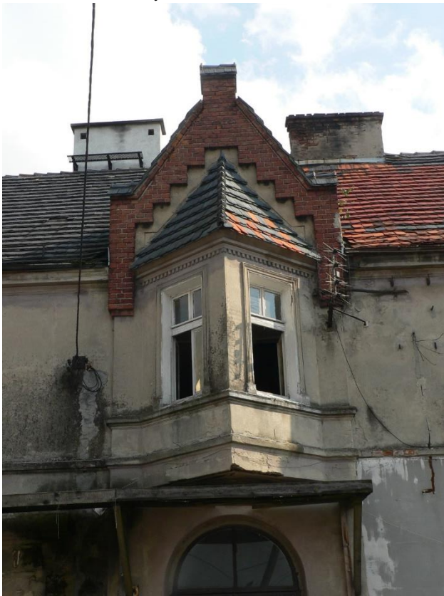
Fot.25 Dach nad wykuszem
