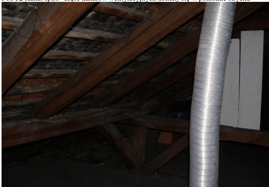
Fot. 52 Kanał spiro- część kanałów wentylacyjnych kończy się w poziomie strychu
