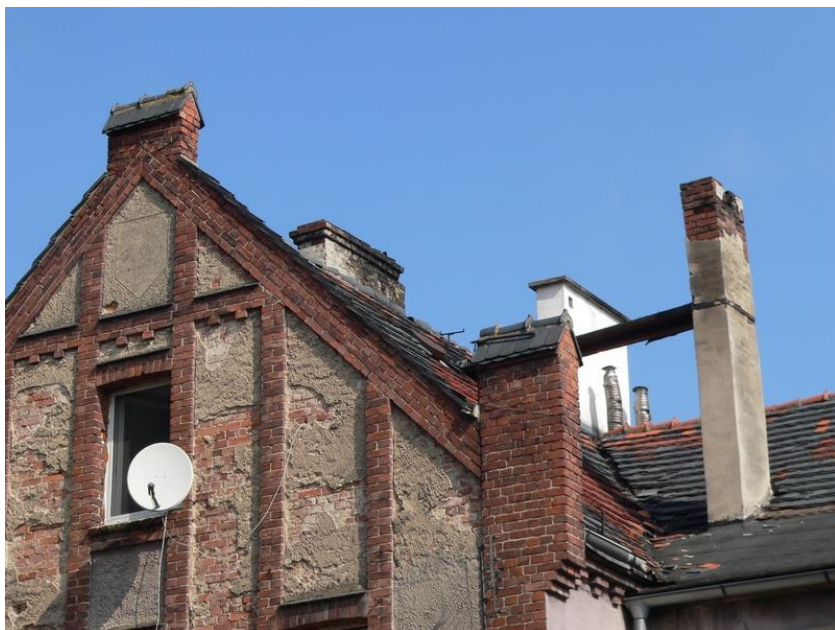
Fot. 8 Widok części papowej połaci , uszkodzona korona komina
