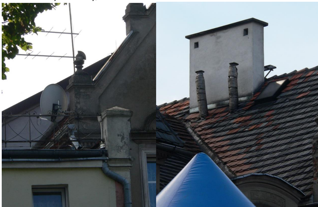
Fot. 42 Komin wyremontowany, kominki went.
