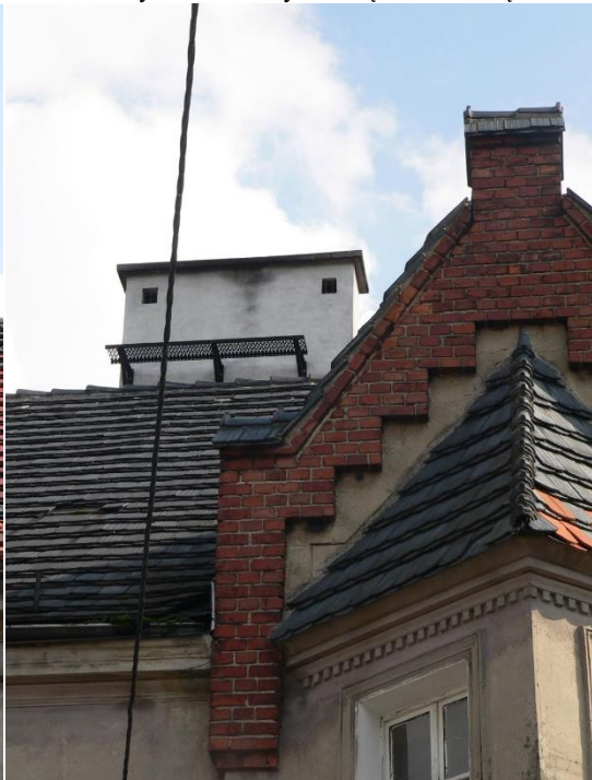
Fot. 29 Komin wyremontowany z ławą kominiarską
