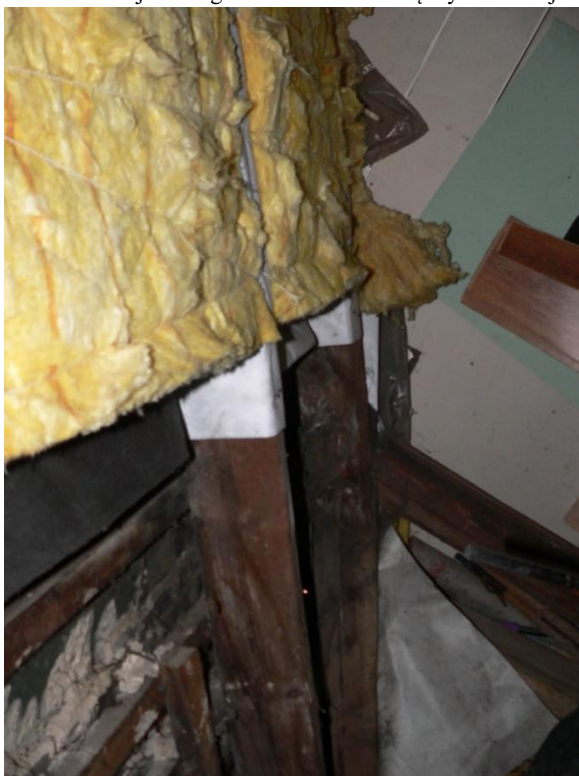
Fot. 74 Korozja biologiczna elementów więźby dachowej
