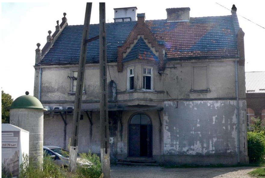
Fot. 2 Uszkodzone zdobienia grzebieni attyk
