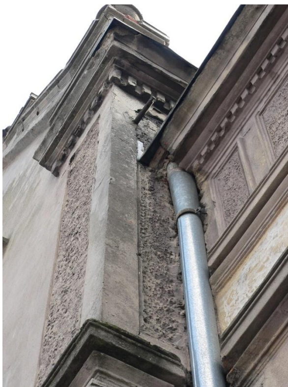
Odwodnienie dachu - rury spustowe Fot. 47
