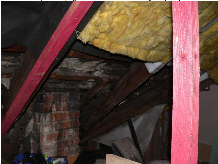
Fot. 74 Korozja biologiczna elementów więźby dachowej
