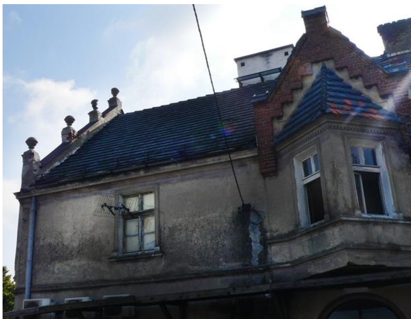
Fot. 2 Uszkodzone zdobienia grzebieni attyk
