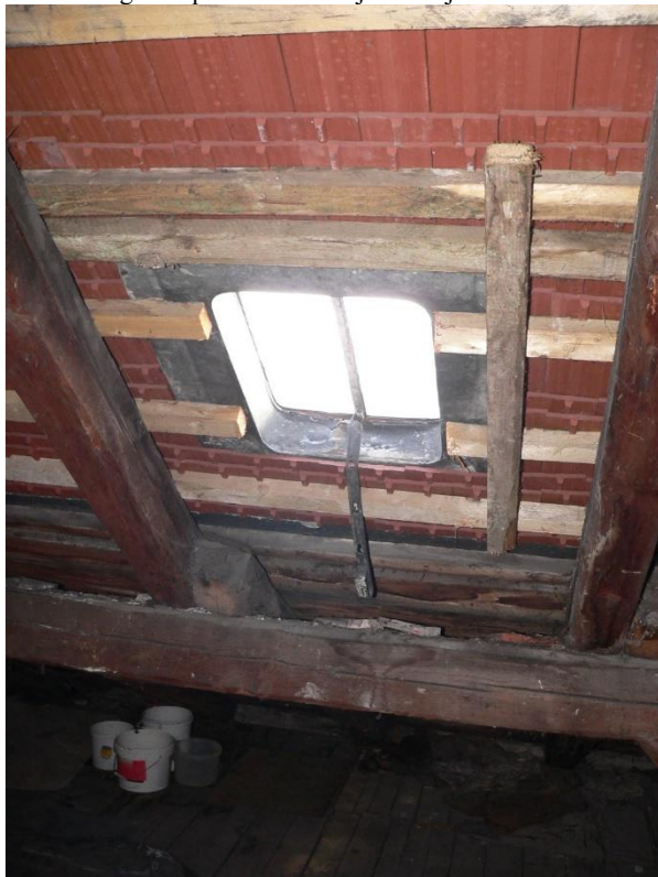
Fot. 61 Fragment połaci dachowej z nowej dachówki
