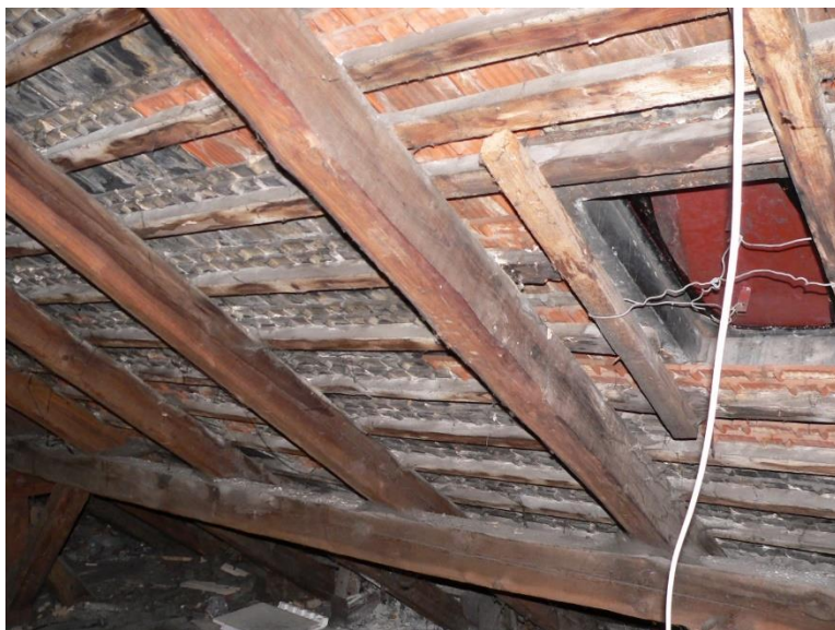
Fot. 51 Krokwie ,okienko wyłazowe
