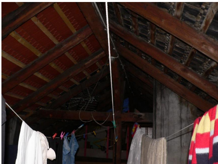
Fot. 50 Belka kalenicowa, krokwie
