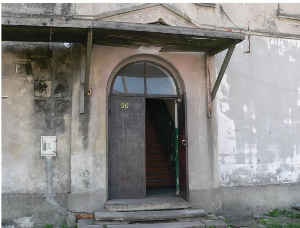
Fot. 4 Tymczasowe zadaszenie nad ciągami pieszych przy budynku
