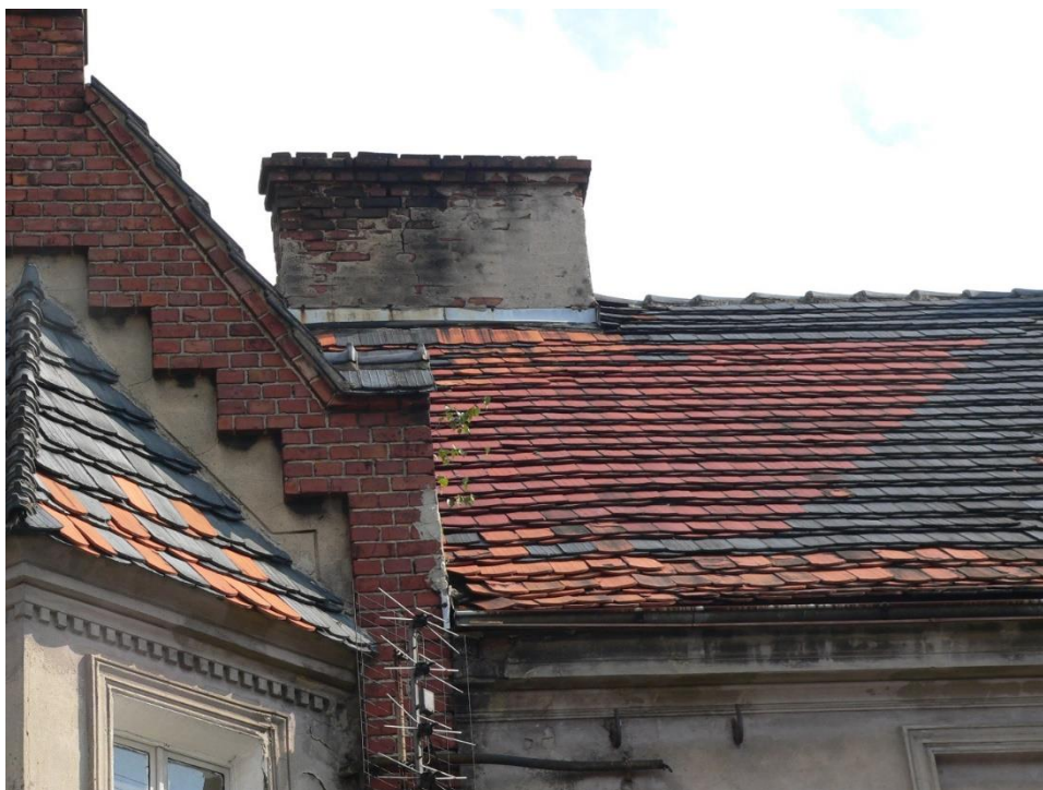
fot. 24 Attyka – zdobienia ,skorodowane obróbki
