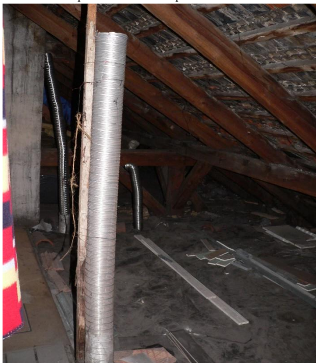
Fot. 60 Kanał spiro zakonczenie w poaci dachu
