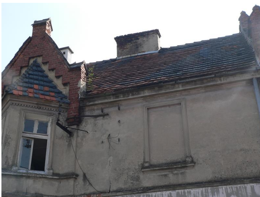
Fot. 10 Uszkodzenia korony komina w połaci od strony wejścia do budynku ul.Wrocławska 50
