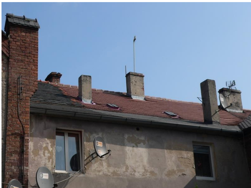
Fot. 8 Widok części papowej połaci , uszkodzona korona komina
