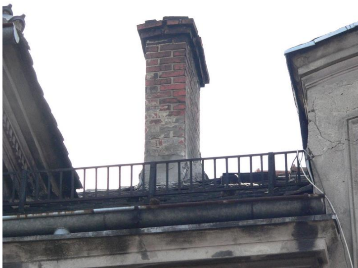
Fot. 22 Daszek zabezpieczający
