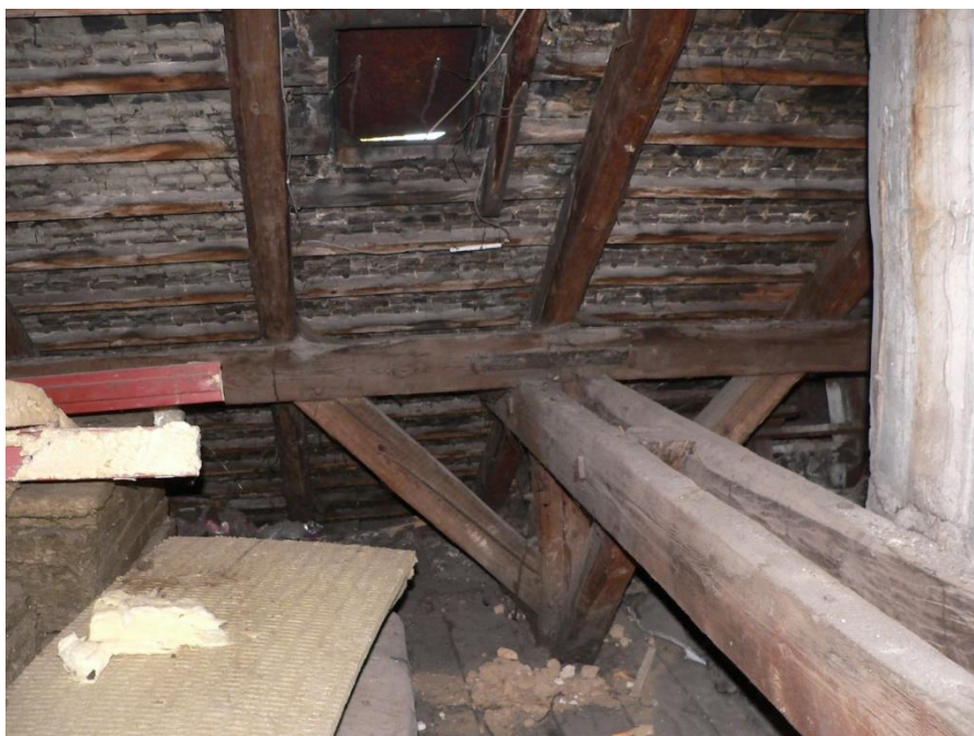
Fot. 71 Okienko wyłazowe- prześwity , brak szczelności
