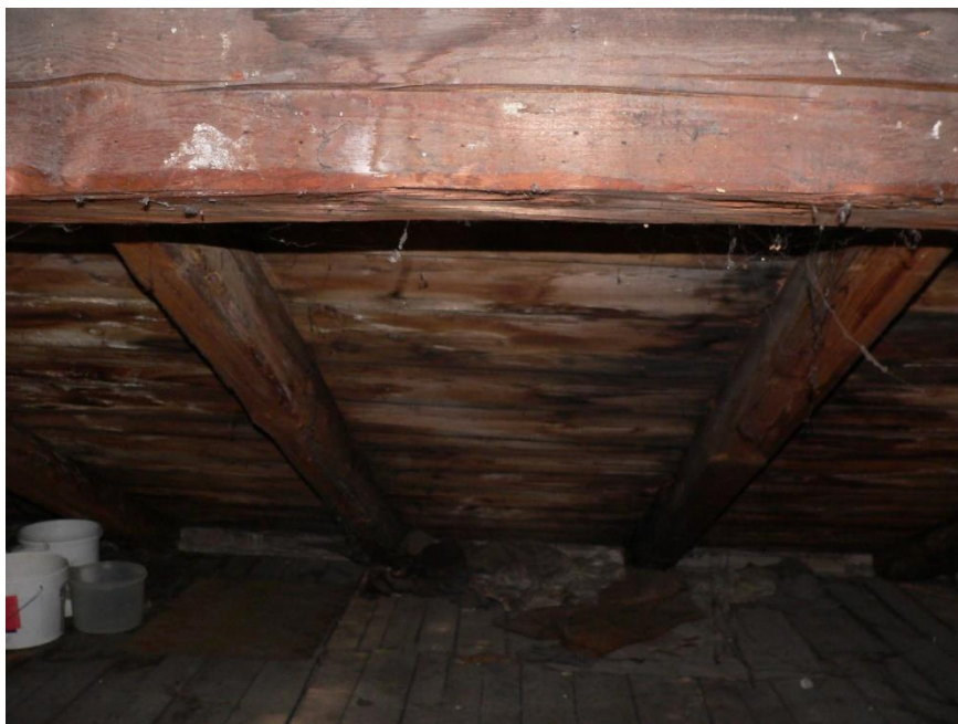
Fot. 62 Fragment połaci odeskowanej ,pokrytej papą
