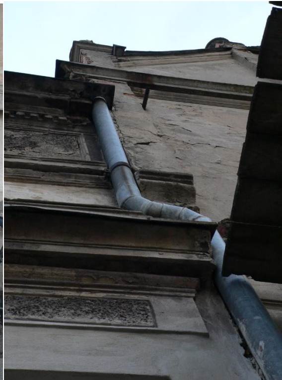
Fot. 44 Wejście rury spustowej do kanalizacji deszczowej Fot. 45 Przejście rury spustowej- gzyms
