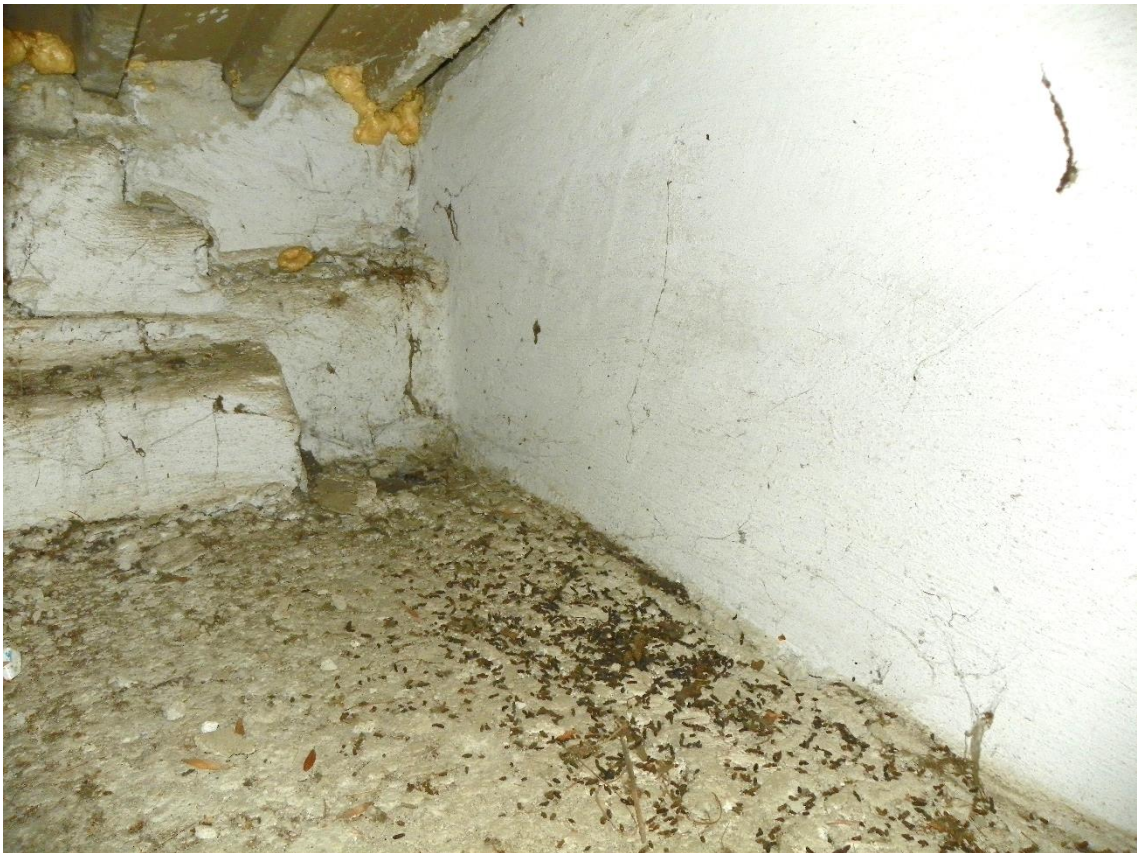
Fot. 14. Ślady wykorzystywania strychu (odchody nietoperzy) części A budynku Zespołu Szkół w Chrząstawie Wielkiej przez nietoperze (stan na dzień 06-06-2016 r.).
