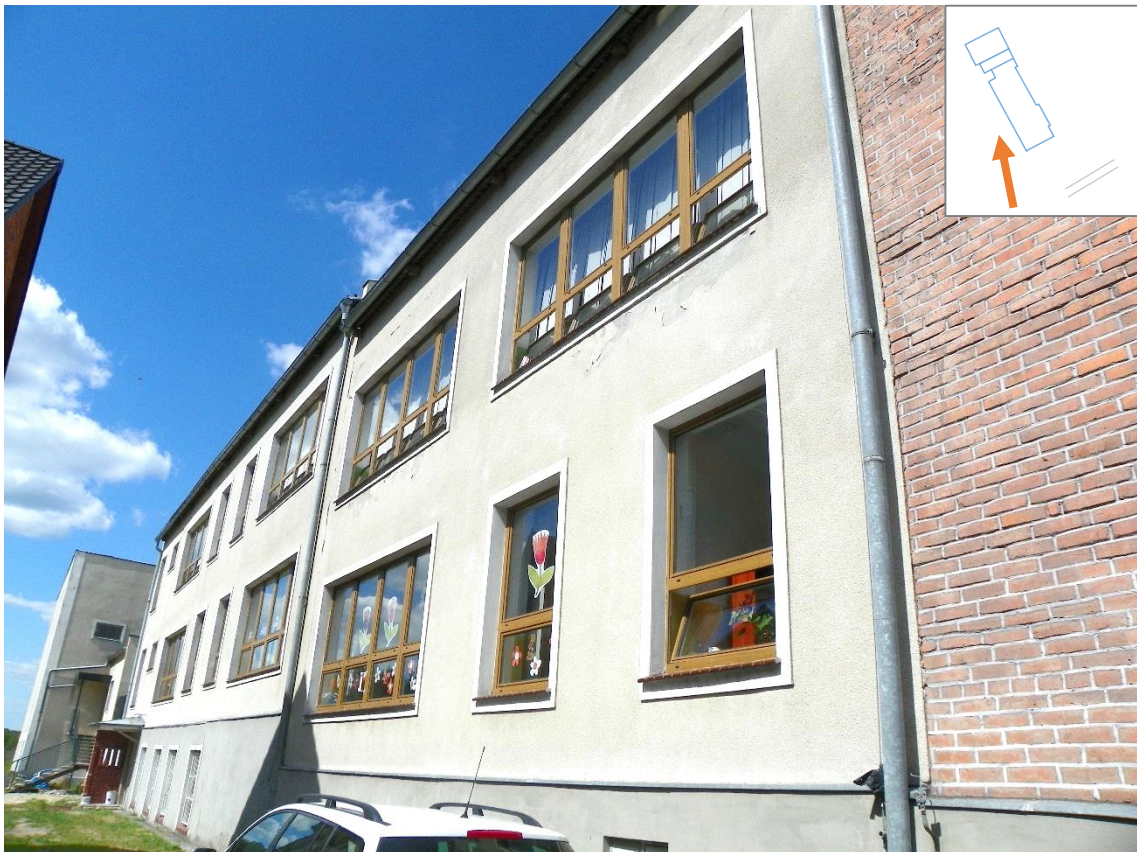
Fot. 4. Ściana A2, B2, C2 budynku Zespołu Szkół w Chrząstawie Wielkiej (stan na dzień 06-06-2016 r.).
