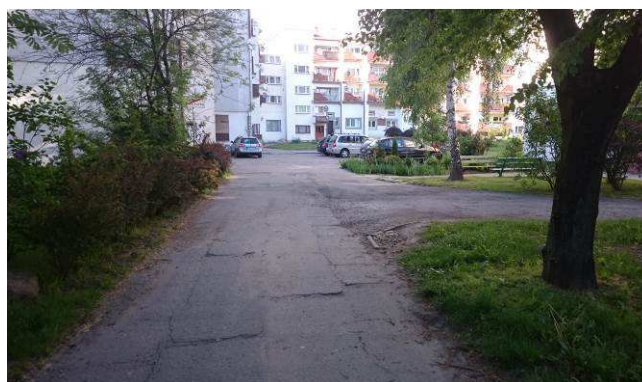
Rys. 3.4 Widok na plac postojowy i zjazd w stronę garaży
