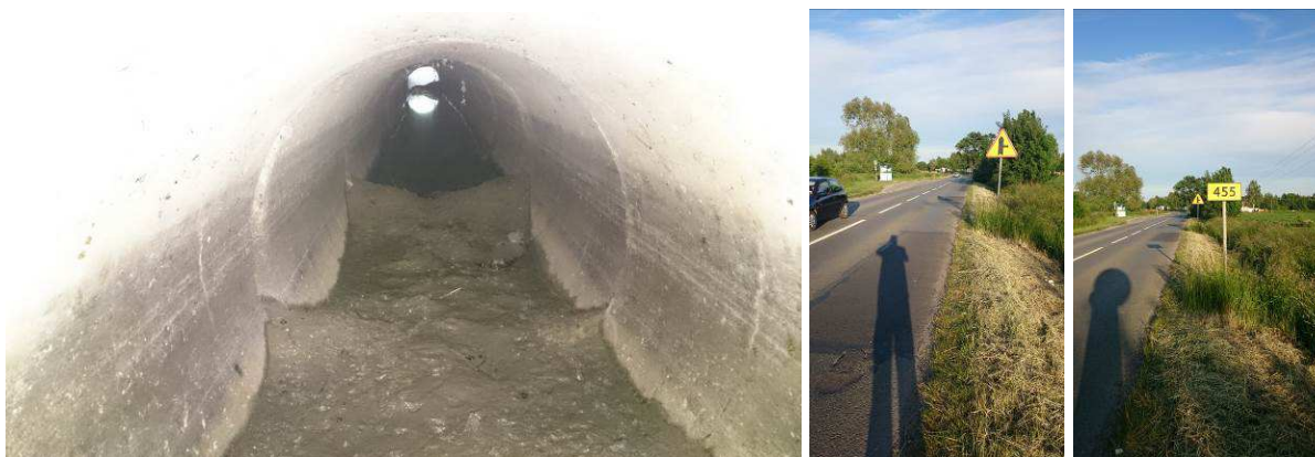
Fot. 1-3. Widok na istniejący przepust pod drogą wojewódzką nr 455 oraz na odcinek drogi wojewódzkiej, na którym planuje się chodnik w ramach przebudowy pasa drogowego.
