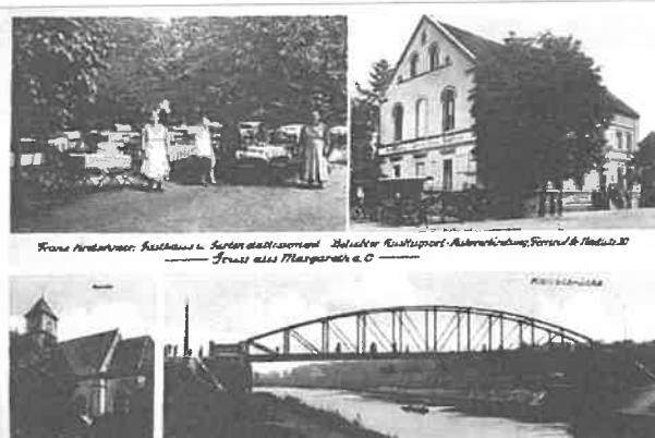
Gajków, gospoda, most na kanale
