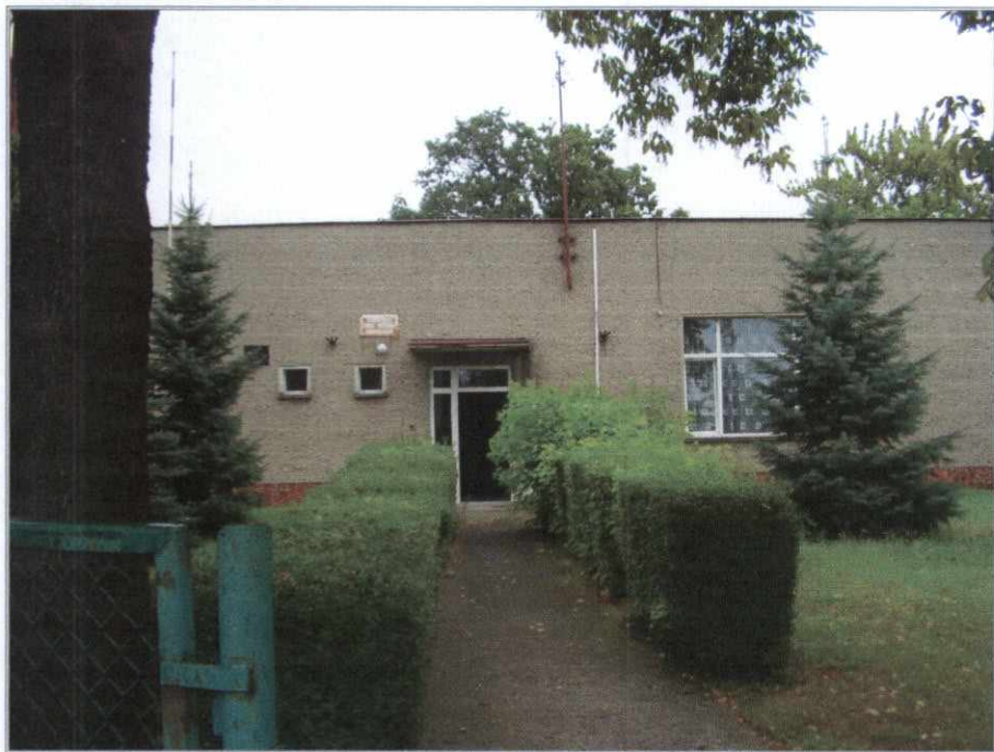
Rozbudowa remizy na świetlicę
